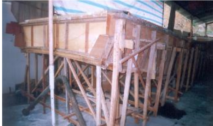
Hình3-3. Kết cấu khuôn gỗ.
